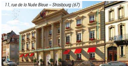
11, rue de la Nuée Bleue – Strasbourg (67)
