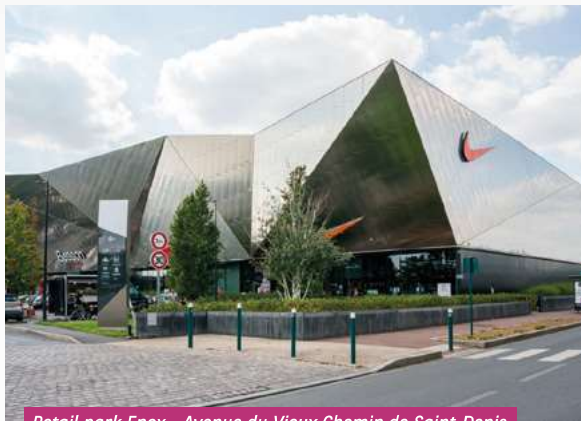
Retail park Enox - Avenue du Vieux Chemin de Saint-Denis Gennevilliers (92)
